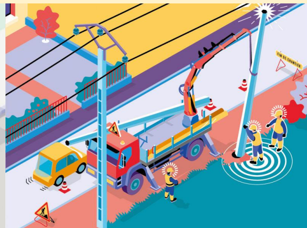
Enfoncement de poteau / piquet / potelet
