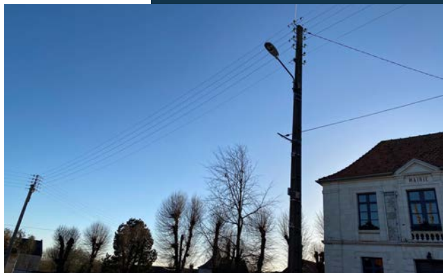
Réseau Basse Tension fils nus
