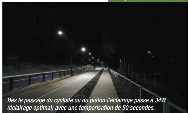
*Dès le passage du cycliste ou du piéton l'éclairage passe à 34W (éclairage optimal) avec une temporisation de 50 secondes.*
