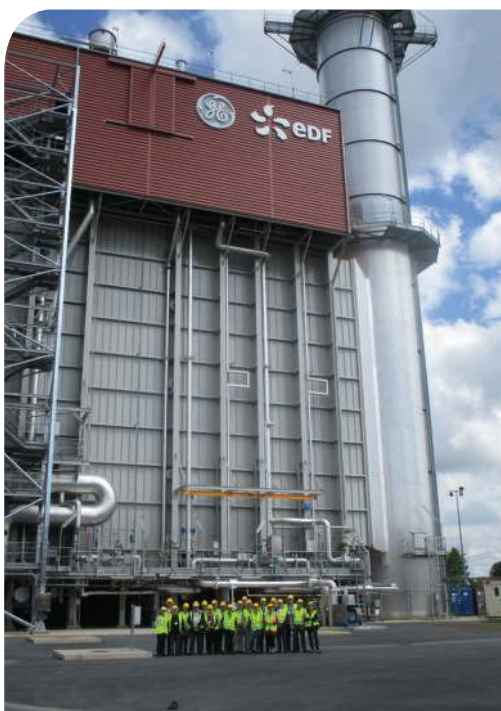
Les associations de consommateurs durant leur visite de la centrale de Bouchain
