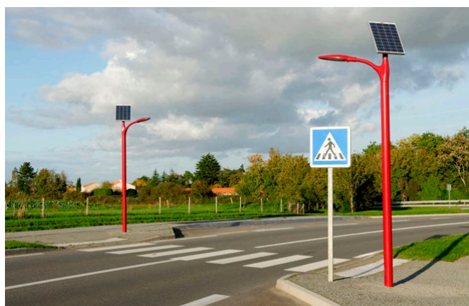
Exemple d'installation de luminaires autonomes à détection de présence pour un passage piéton
