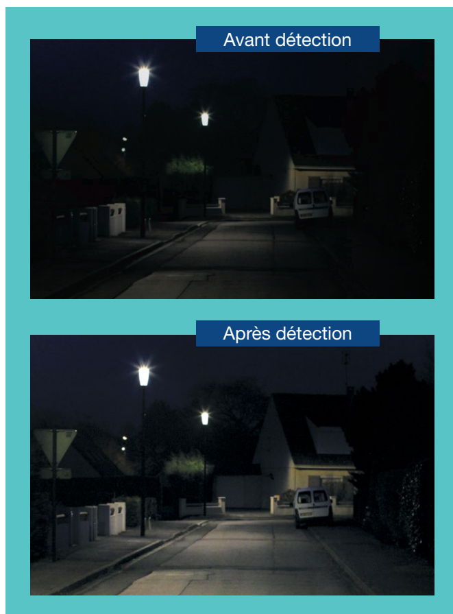
Aménagement d'une impasse résidentielle à Condette. La détection de présence communicante permet de piloter un ensemble de luminaires LED suite à la détection d'un piéton, d'un cycliste ou d'une voiture.
